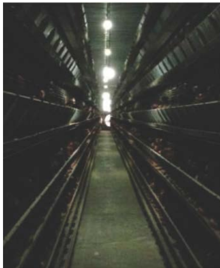
Figura 18. Las luces LED instaladas en este galpón están colocadas demasiado direccionales, muy separadas y no son suficientemente brillantes. La combinación de estos factores conducen obviamente a sombras en el piso y a una mala uniformidad de luz en las jaulas.
